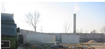
Gradilište objekta Pritvorske jedinice, novembar 2004.
